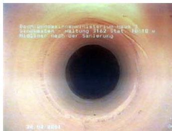
Bild 11: Ausgehärteter Kurzliner (Quelle: Fa. Rainer Kiel)
