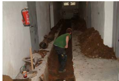
Bild 25: Erneuerung in offener Bauweise (Quelle: Fa. Rainer Kiel)
