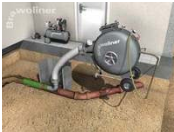
Bild 15: Einbringen des Liners in die Leitung (Quelle: BRAWOLINER®)
