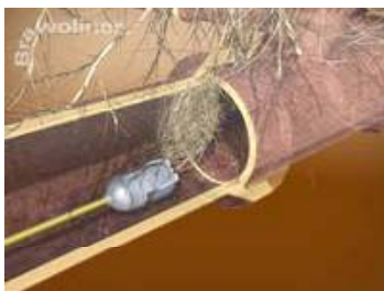
Bild 12: Beseitigung von Wurzeln (Quelle: BRAWOLINER®)
