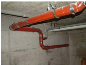
Bild 24: Abhängen von Leitungen (Quelle: Fa. Rainer Kiel)
